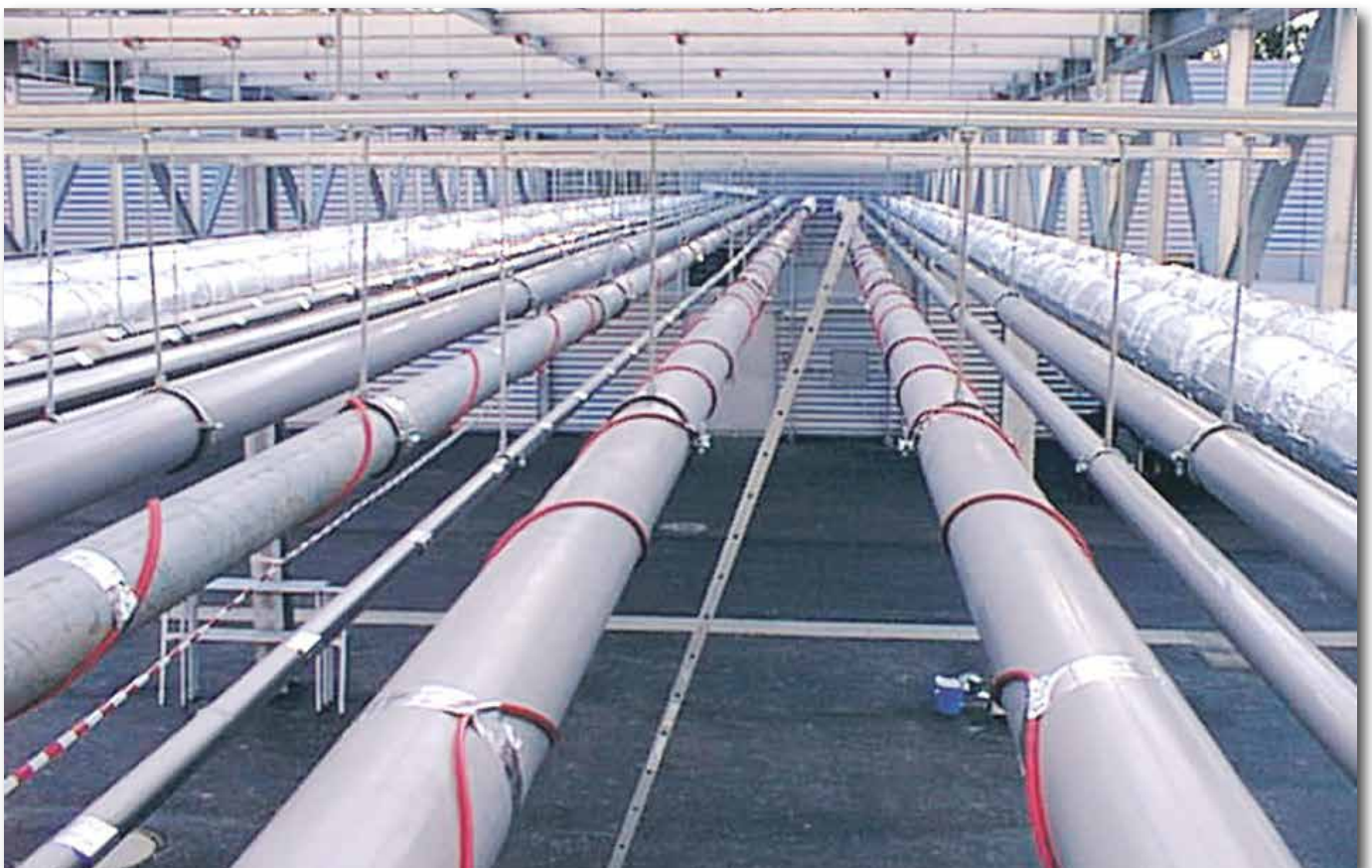
Beheizte Rohre vor den Isolierarbeiten
